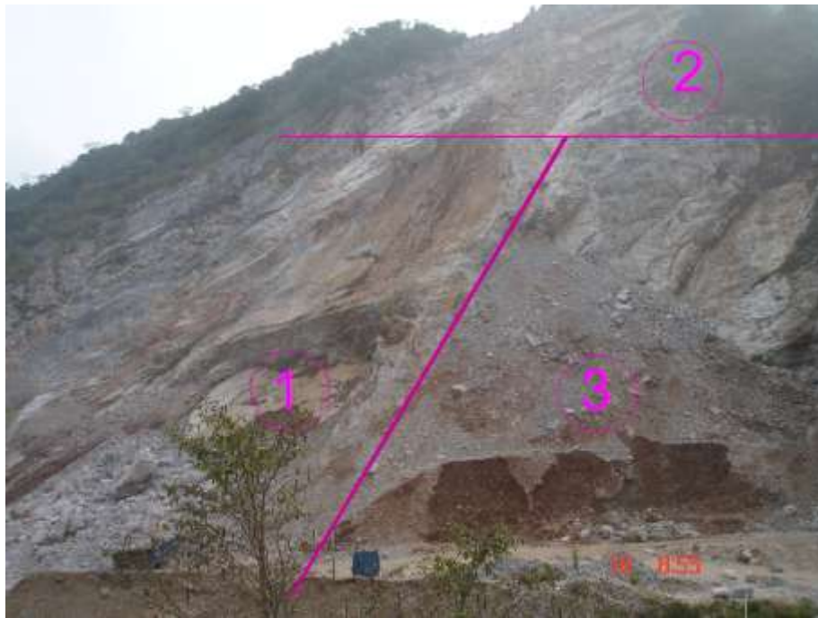
Hình 3.14. Sơ đồ xác định vị trí cải tạo mỏ với 1, 2 và 3 là trình tự cải tạo [28]
